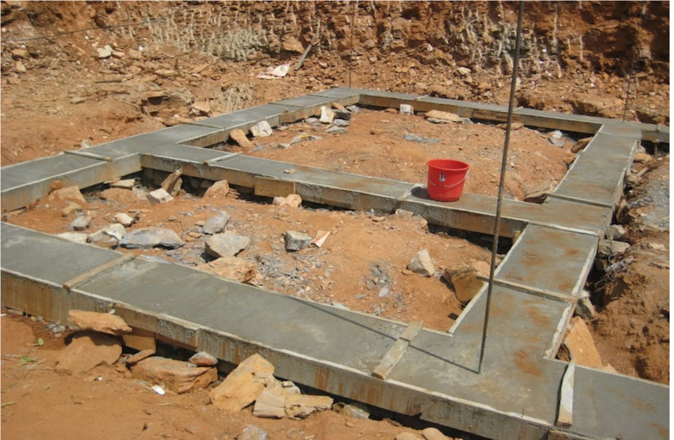
Das Fundament eines Kinderhauses, frisch betoniert.
