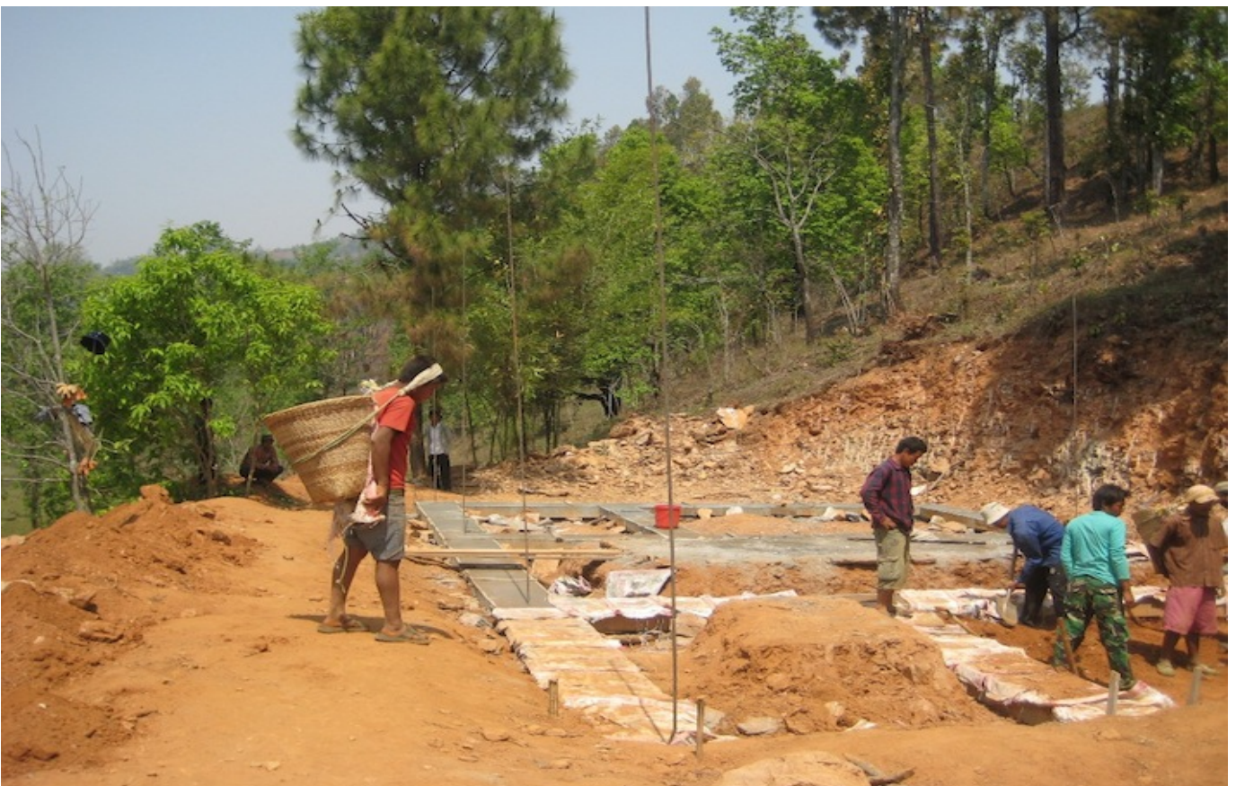
Die Arbeiter beim betonieren eines weiteren Fundamentes.
