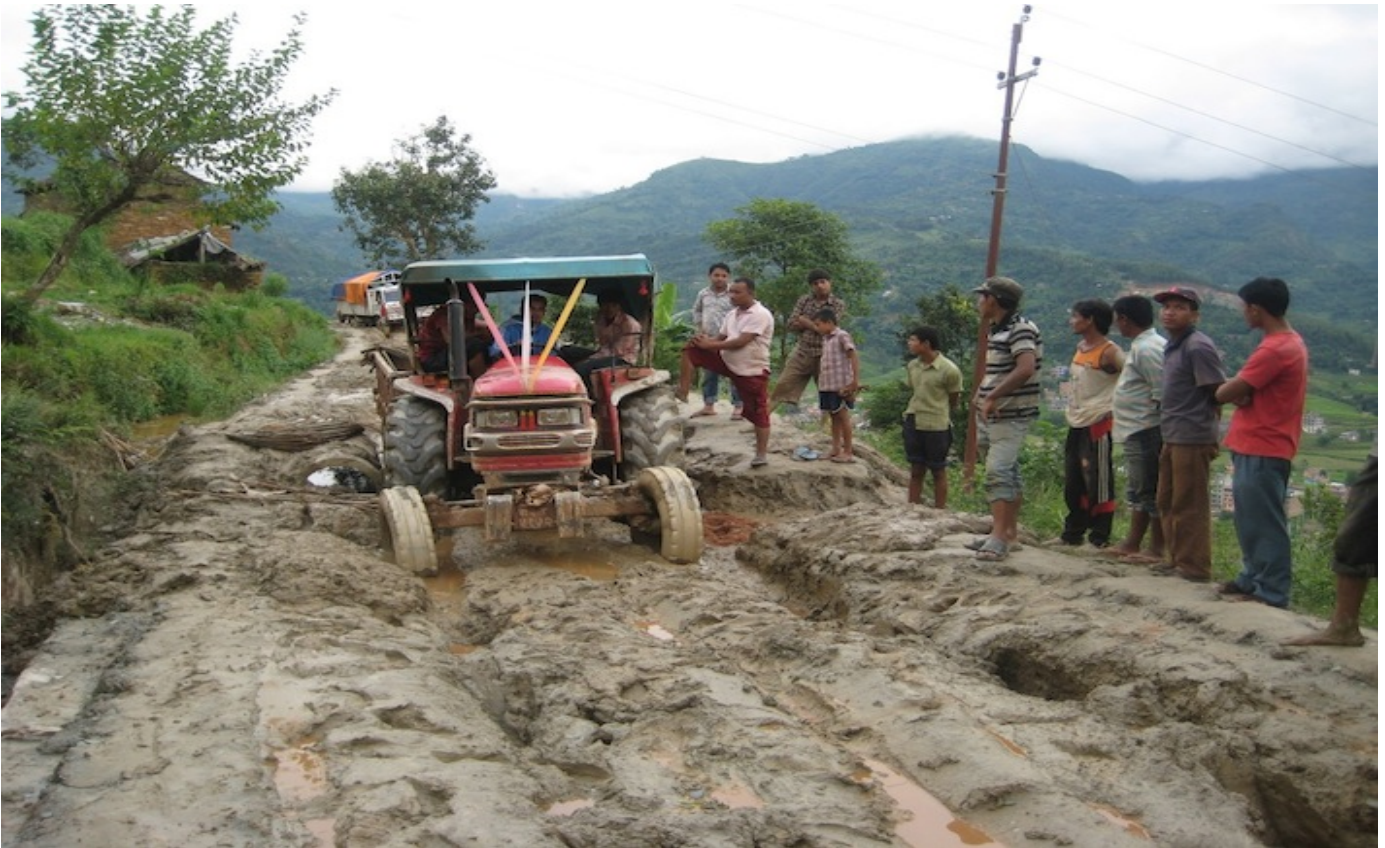
Der Materialtransport wird durch den lange anhaltenden Monsunregen sehr stark beeinträchtigt. Auf dem Bild ist die total aufgeweichte Zufahrtsstrasse zum Kinderdorf zu sehen.
