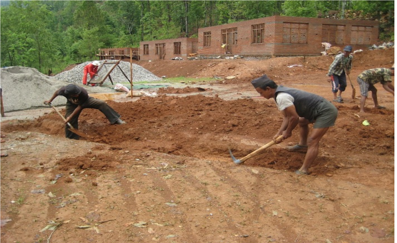
Hier werden die Fundamente für die nächsten Häuser gegraben. Im Hintergrund die 3 Häuser, die schon „fast fertig“ sind. Die Mauerwerke stehen, es müssen noch die Dächer gebaut und der Innenausbau fertig gestellt werden.
