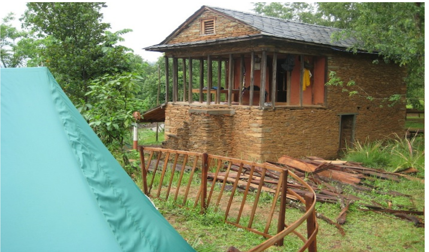
Das „alte Haus“ wurde renoviert und eingerichtet und dient zur Unterkunft der beiden Wachmänner.
