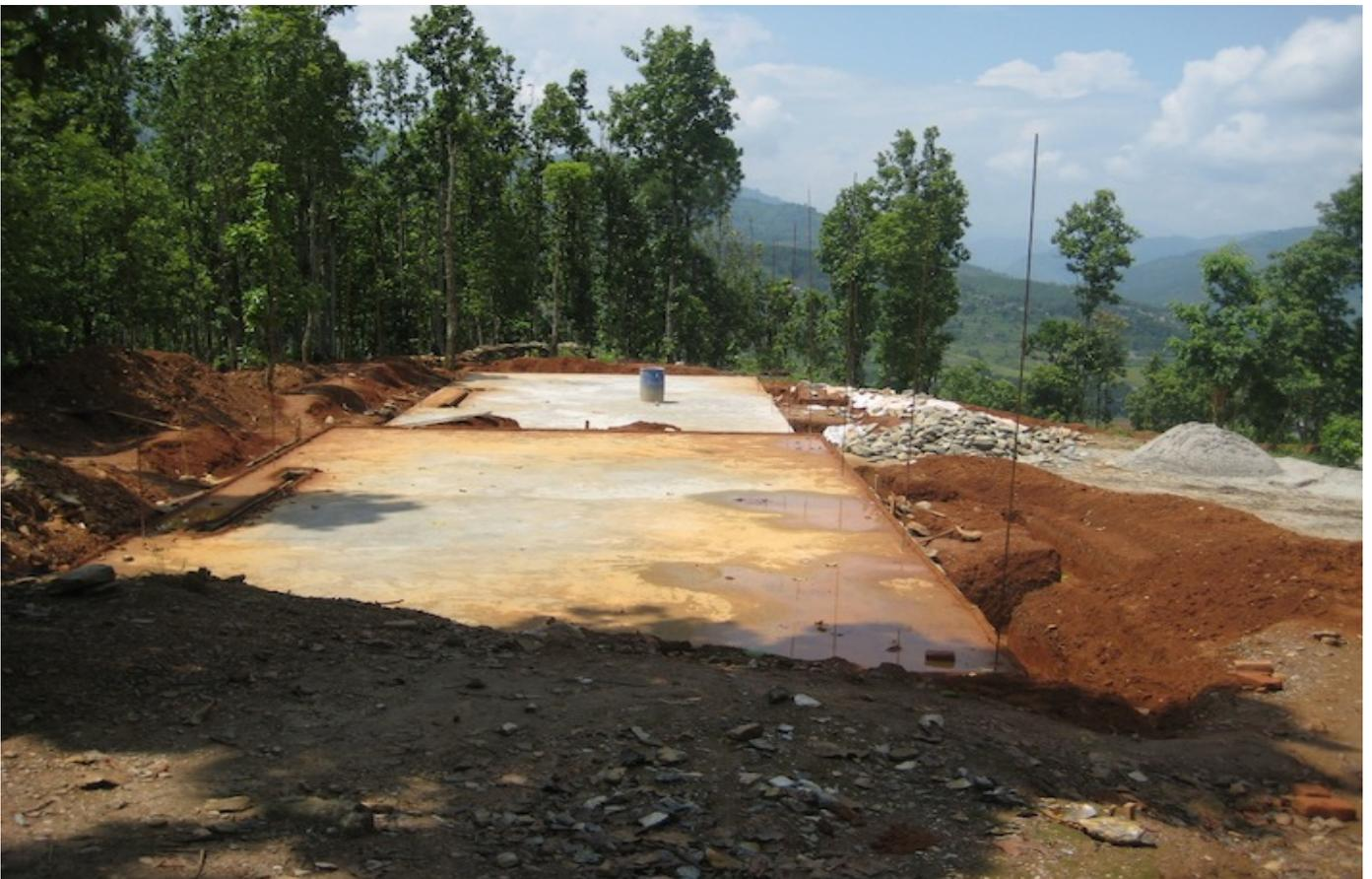
Hier sind die fertigen Fundamente für die Häuser 4 und 5.
