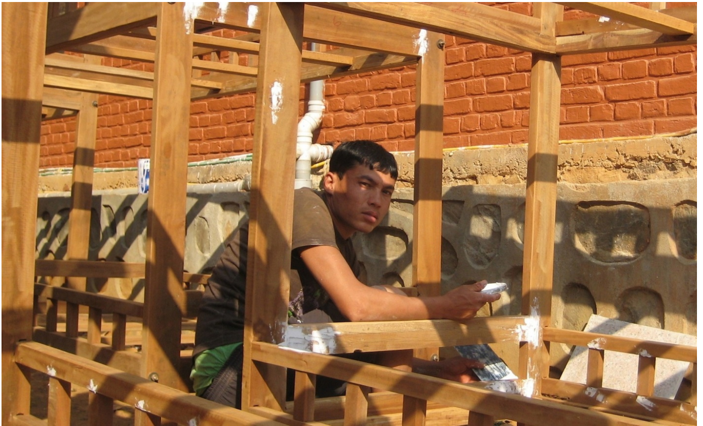
Schritt für Schritt geht es weiter mit der Einrichtung der sechs Kinderhäuser. Einige neue Betten bekommen noch schnell ihrem Anstrich.
