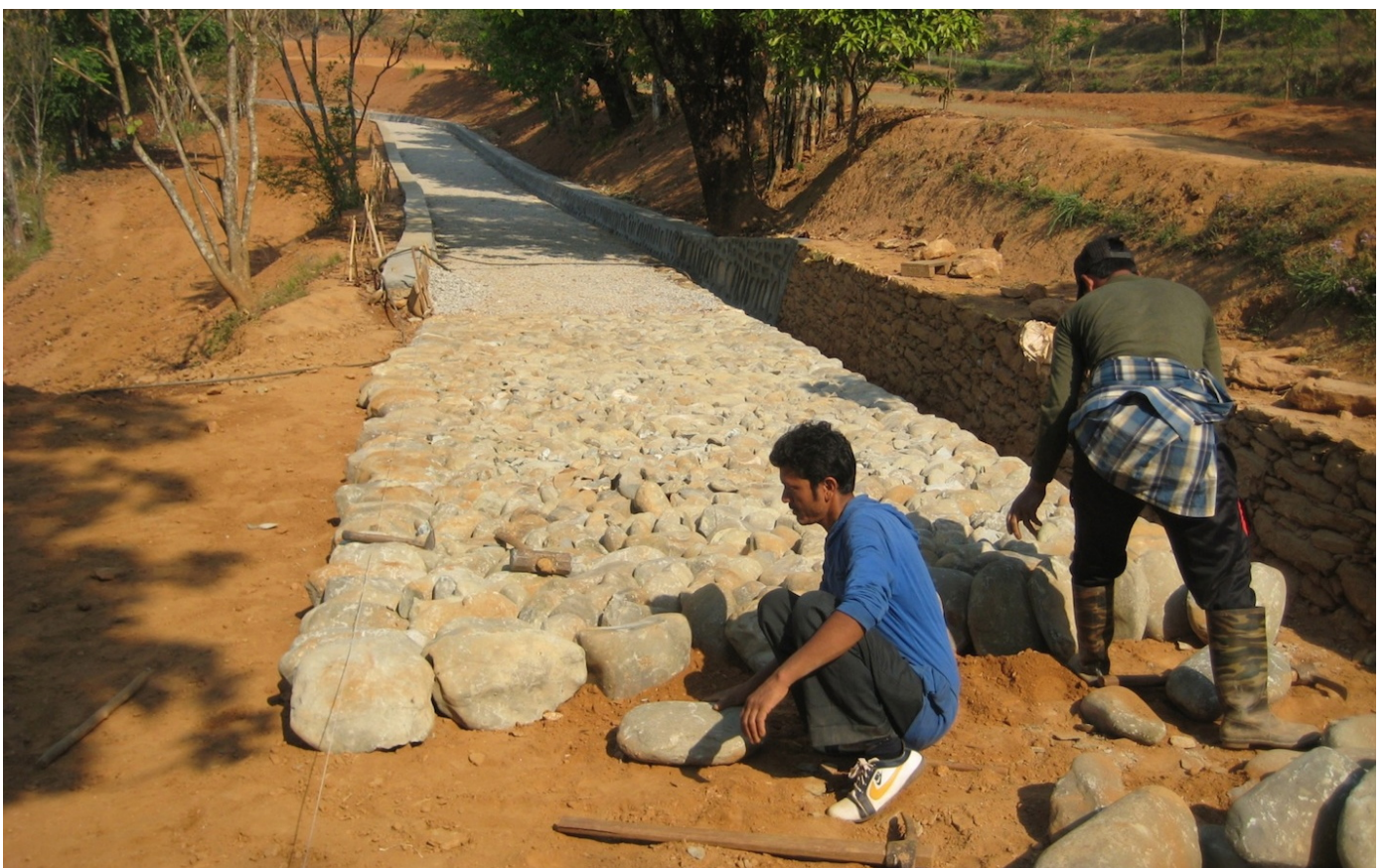
Gehwege im Kinderdorf werden mit Steinen ausgelegt, um gegen Staub und Schmutz gefeit zu sein.
