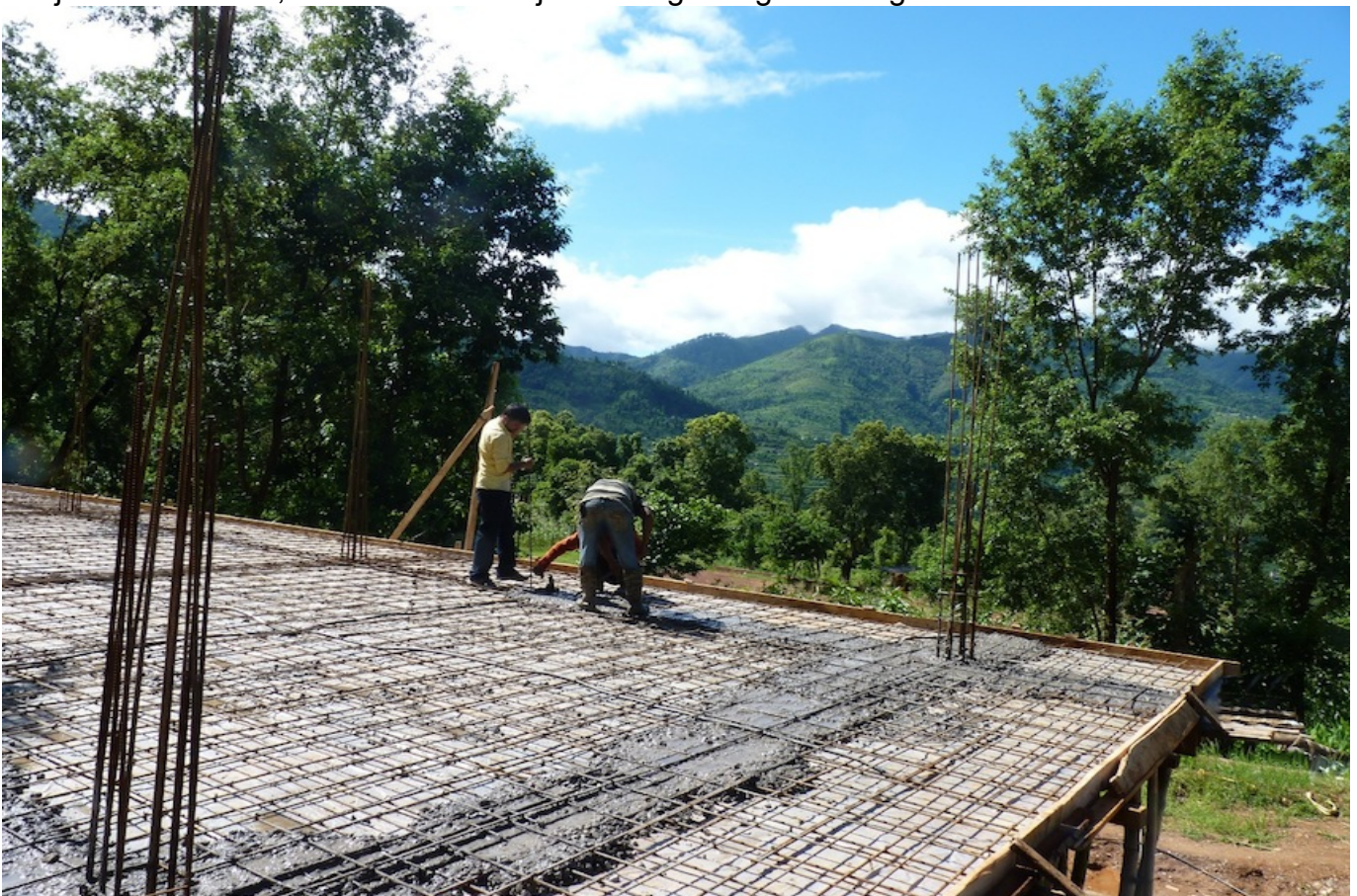
5. Der Kuhstall wird derzeit erweitert und mit einem Aufbau versehen, um den Tieren ausreichend Platz zu bieten und Futtermittel unterzubringen.
