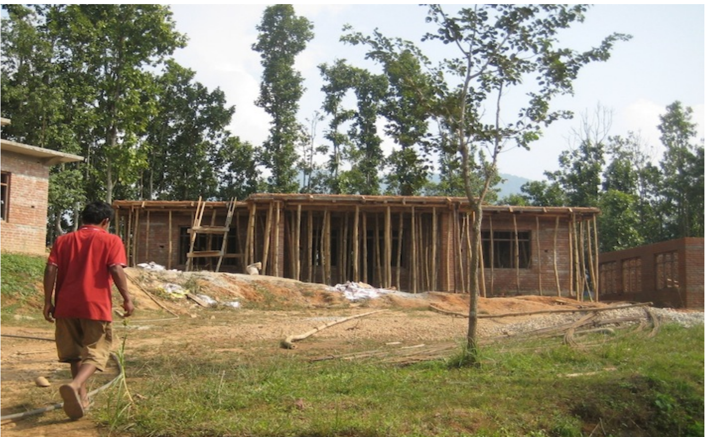
Beim Haus Nummer 4 wurde gerade das Dach fertig gestellt.
