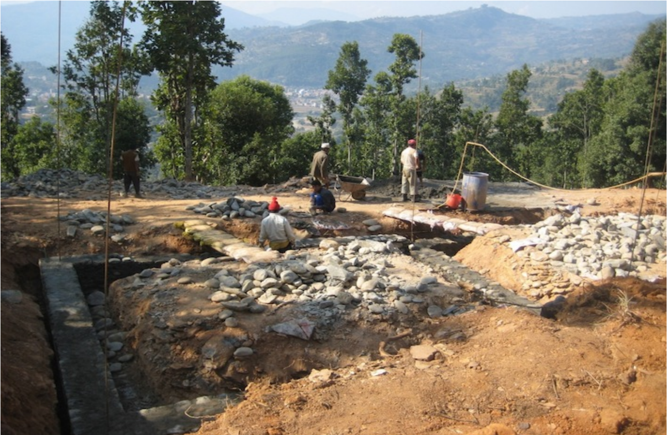
Hier ist das Fundament des Study-Center, Raum 1 und Raum 2 zu sehen.
