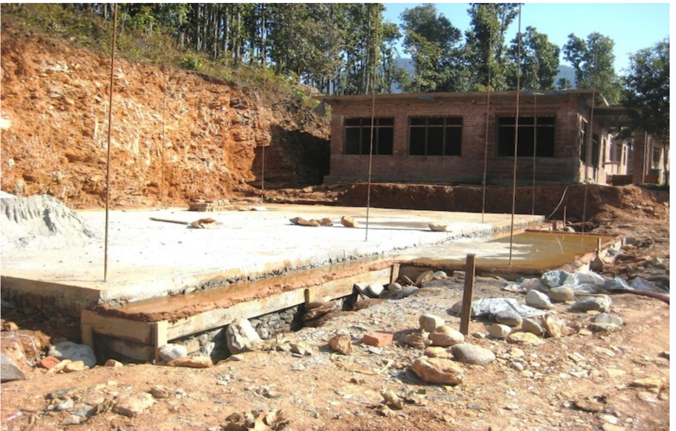
Fundament des Kinderhauses Nr. 6
