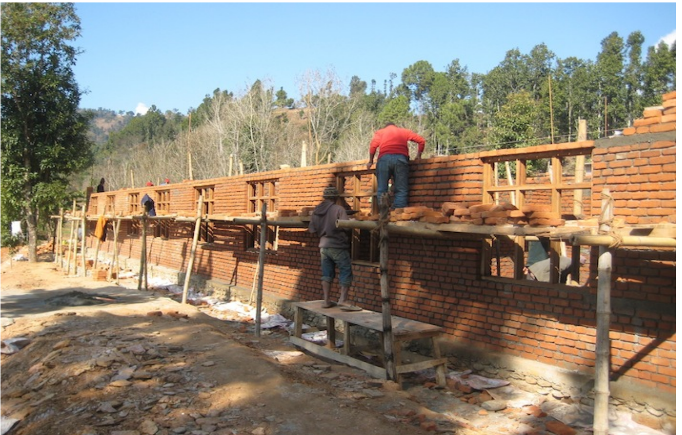
Bauarbeiter beim Arbeiten an der Südseite des Study Center.
