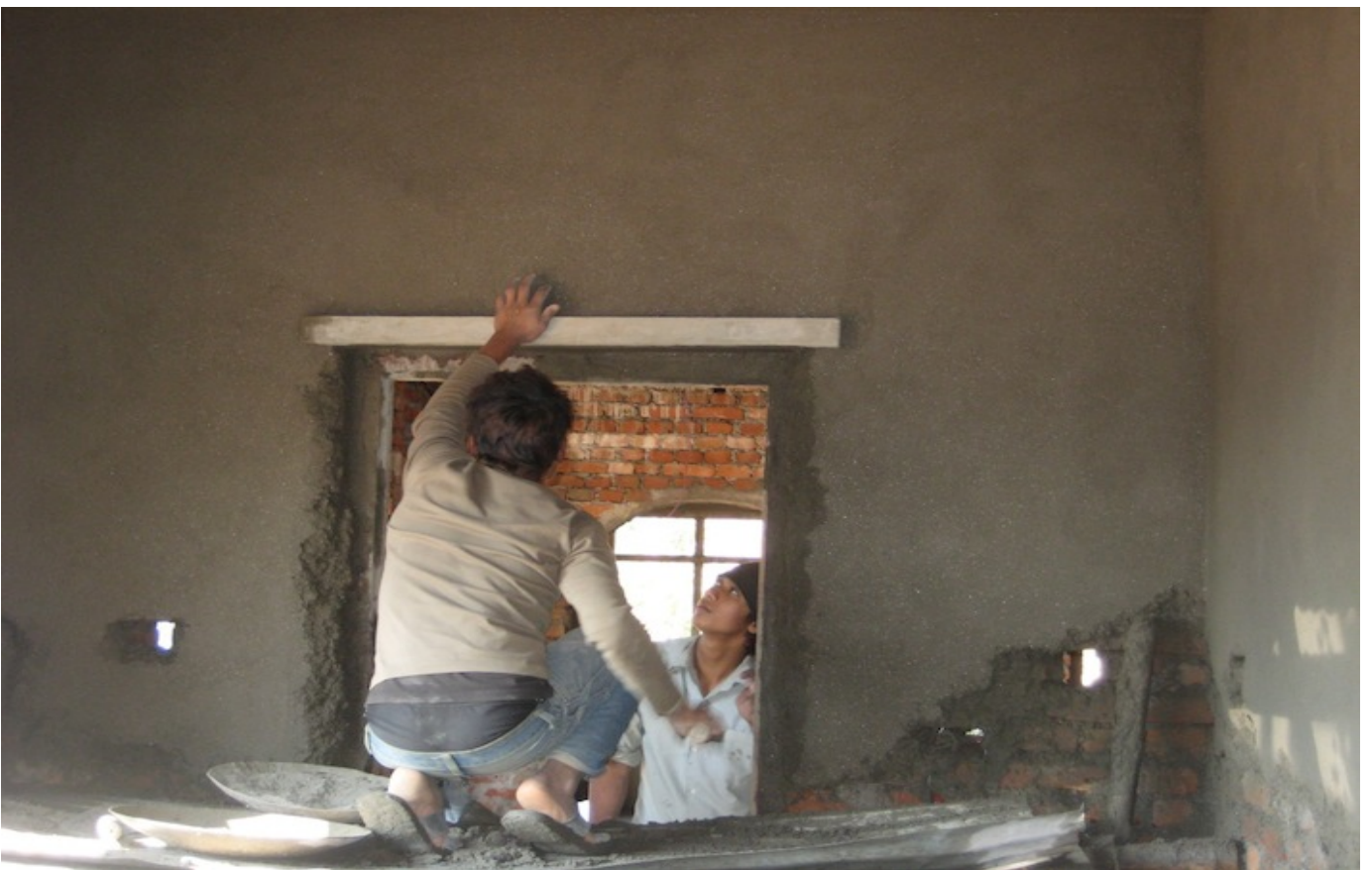
Bauarbeiter beim Verputzen der Innenwände.
