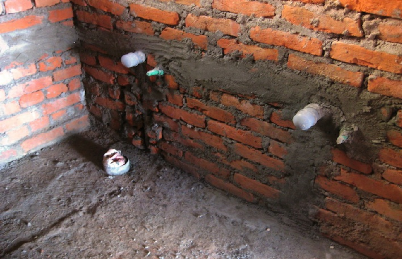
Wasserrohrverlegung in den Kinderhäusern.
