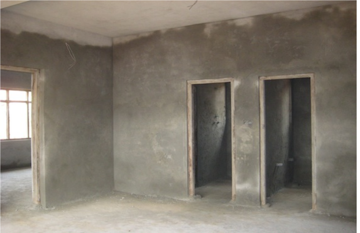
Kinderhaus von Innen, die Verputzarbeiten sind fast abgeschlossen.
