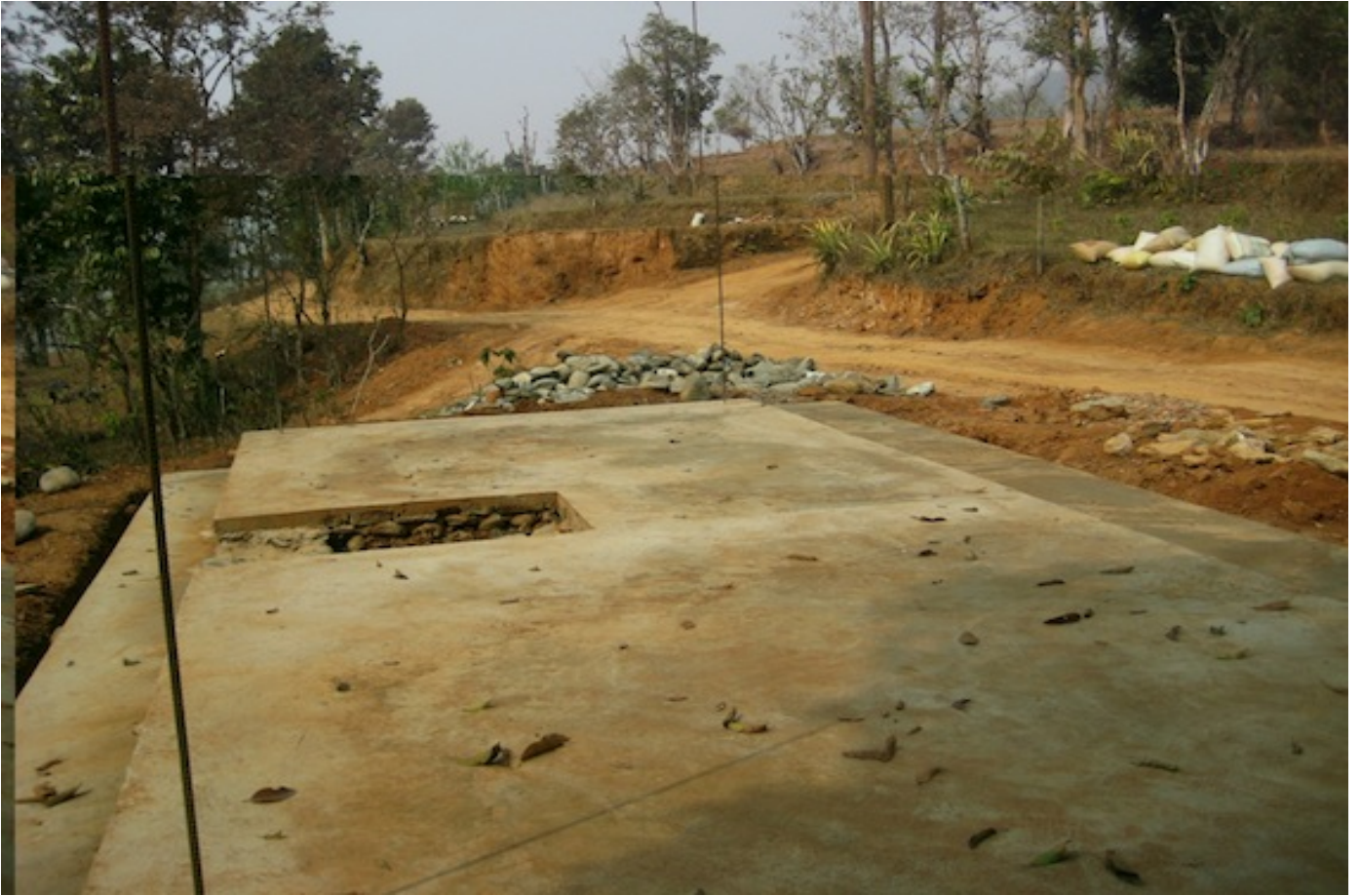
Fundament für das Wächterhaus im Eingangsbereich.
