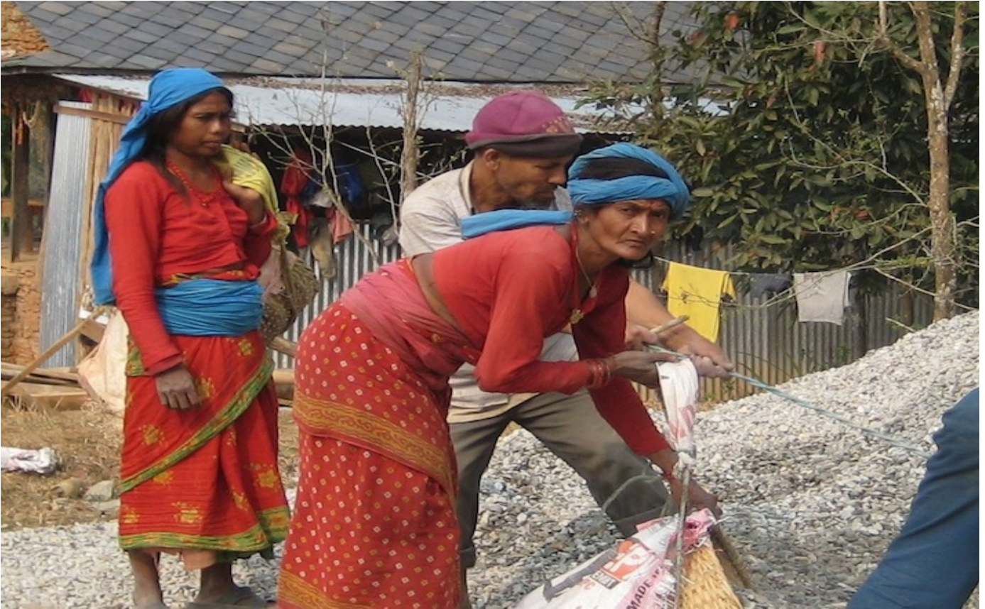
Frauen und Männer arbeiten gemeinsam auf der Baustelle.
