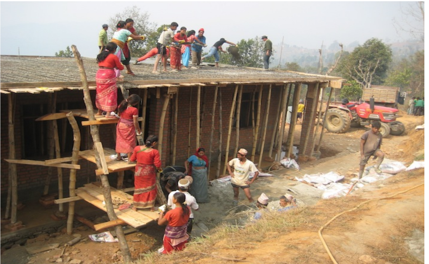
Arbeiten am Dach des Study-Center.
