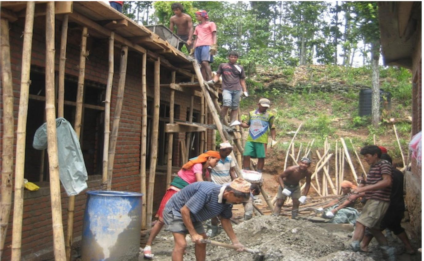
Die Arbeiter mischen Beton für die Arbeiten auf dem Dach. Hier ist gut zu erkennen, dass Vieles mit Handarbeit gemacht wird und viele Hände benötigt werden.
