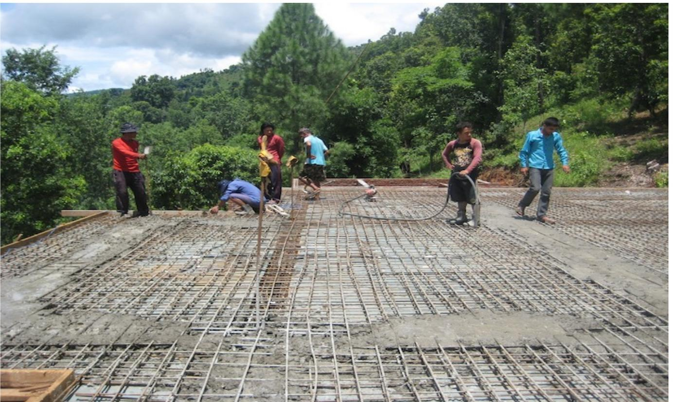
Hier sind die Arbeiter gerade dabei das nächste Dach zu betonieren.
