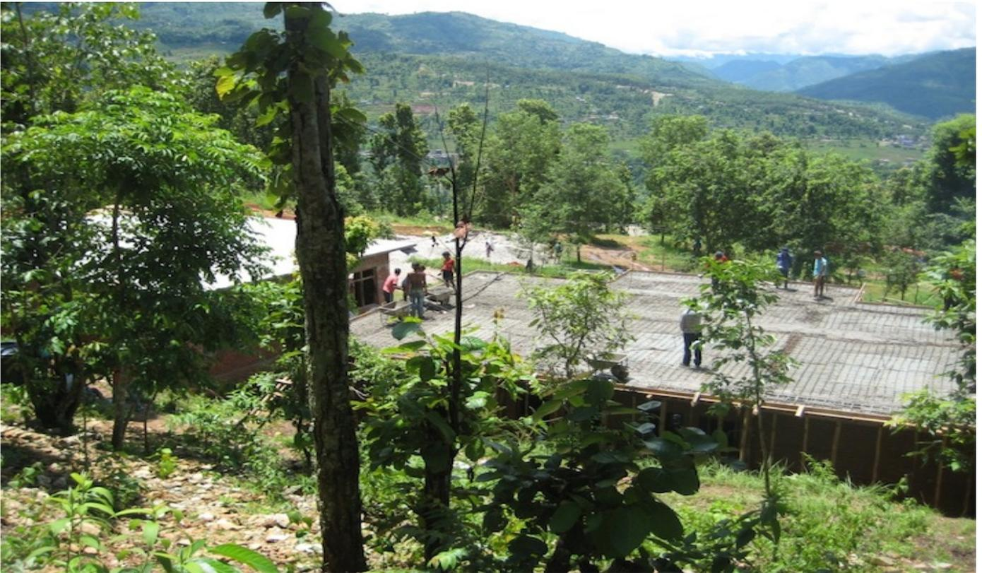
Auf dem Bild ist zu erkennen, dass die ersten beiden Häuser bereits ein Dach haben, hier handelt es sich um die Unterkonstruktion , die betoniert wird.
